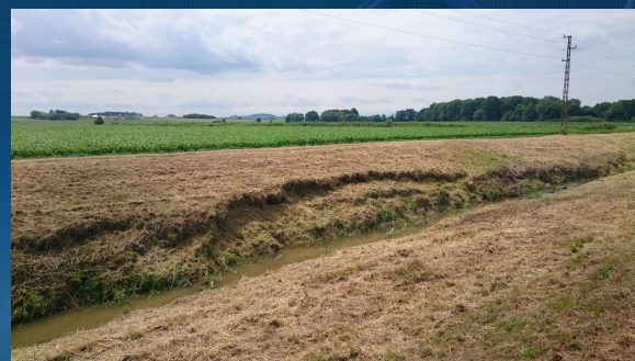
Uszkodzenia skarp rz. Ślęzy zagrażające bezpieczeństwu wałów przeciwpowodziowych (fot. WTU sp. z o.o.)
